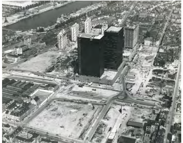
Fig 8. Vue des deux premières tours du World Trade Center et des terrains démolis autour de l'ancien parvis Saint-Roch. Première moitié des années 1970. Fonds Charles de Pauw, Archives du CIVA.
