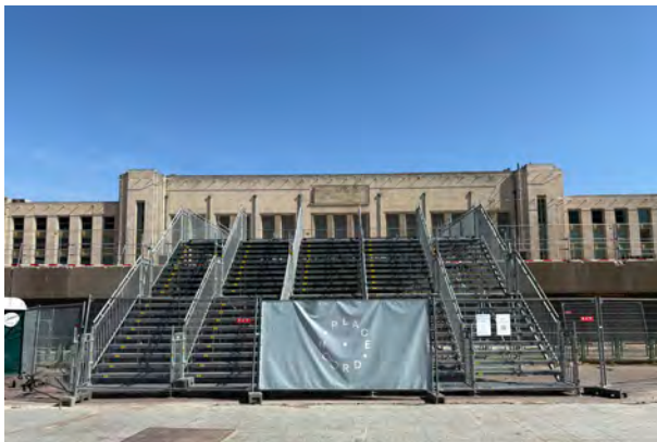
Fig 81. L'accès à l'occupation temporaire de la dalle de l'ancien Centre de Communication Nord situé devant la Gare du Nord. La démolition du CCN permettra la construction du complexe immobilier NOR.Brussels. Été 2025. Photo de Geoffrey Grulois.
