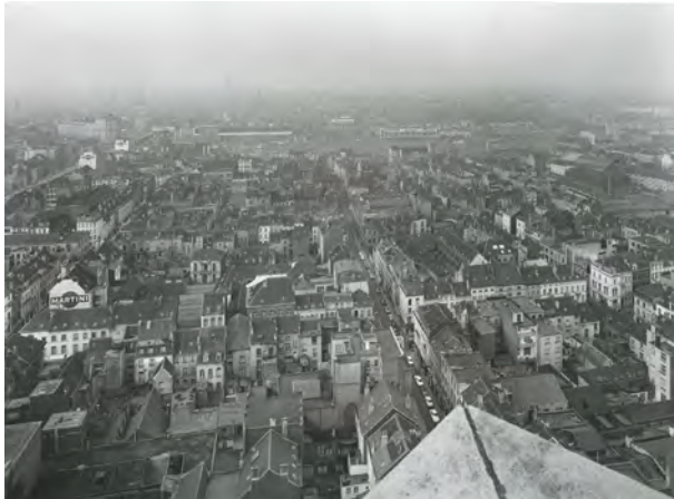
Fig 7. Vue du quartier autour de la Gare du Nord dans les années 1950. Fonds Charles de Pauw, Archives du CIVA.
