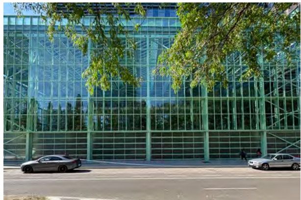
Fig 82. La façade de la serre végétalisée du complexe immobilier ZIN avec les parois vitrées fermées en dehors des heures de bureau. Été 2025. Photo de Geoffrey Grulois.
