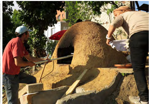
Fig 69. Four à pain réalisé par un habitant dans le cadre de Parcfarm. Printemps 2014. Photo de Taktyk et Alive Architecture.
