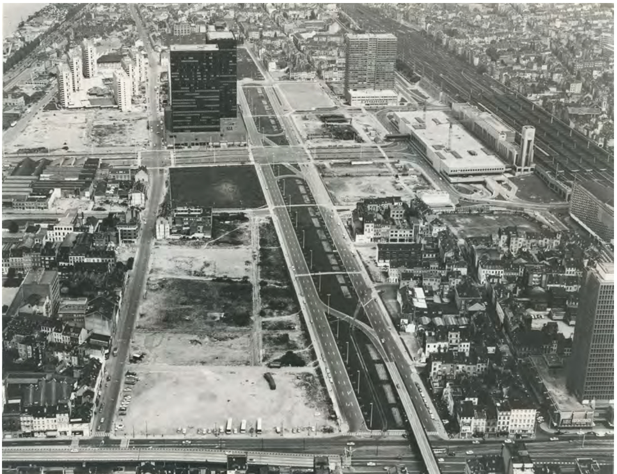
Fig 9. Vue du Quartier Nord après la construction des Boulevard Albert II et Simon Bolivar et de la dalle du Centre de Communication Nord. Deuxième moitié des années 1970. Fonds Charles de Pauw, Archives du CIVA.
